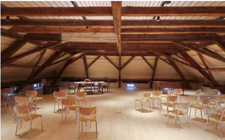
Der neue Saal im Dachgeschoss wird von der Konstruktion von 1867 geprägt.
